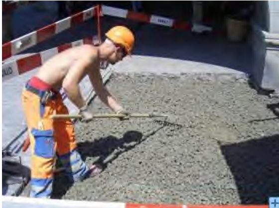
Sickerbeton als Fundament
