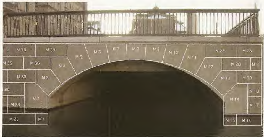
Für den Bau der Ufermauer und eines neuen Vorplatzes (Zeichnung) sowie für die Rekonstruktion einer Brückenkanel waren bis zu 2,5 t schwere Werkstücke zu versetzen.
