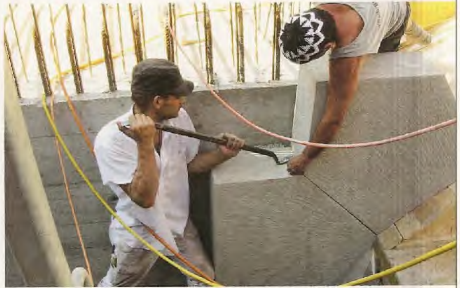
oben: Basaltkleinpflaster im Bereich eines Restaurants unten: Versetzen großformatige Werkstücke aus Bollinger Sandstein
